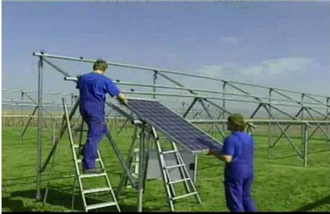
Монтажа на носечка конструкција и PV модули.
