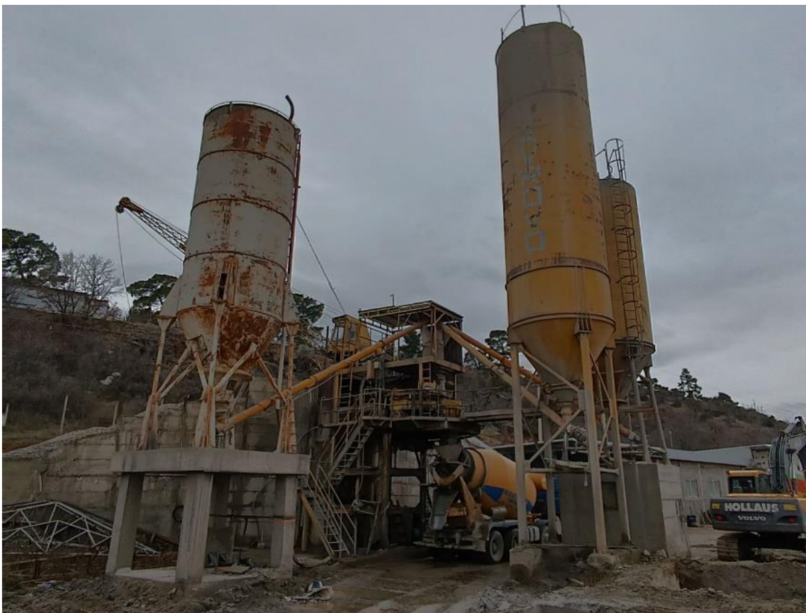
Слика 4. Бетонска база Пелагонија ТИРИЦ Гевгелија
