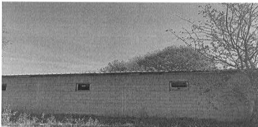
Сл.9 Изглед на конструкцијата на еден од објектите
