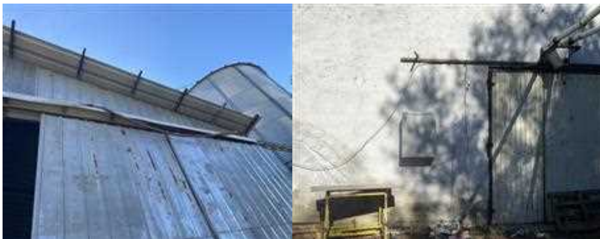
Сл.32 Електрична инсталација
