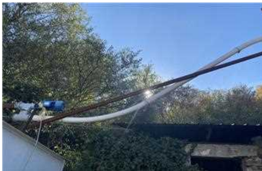
Сл.21 Поврзаност на системот за хранење од млино до објектот за одгледување на свињи
