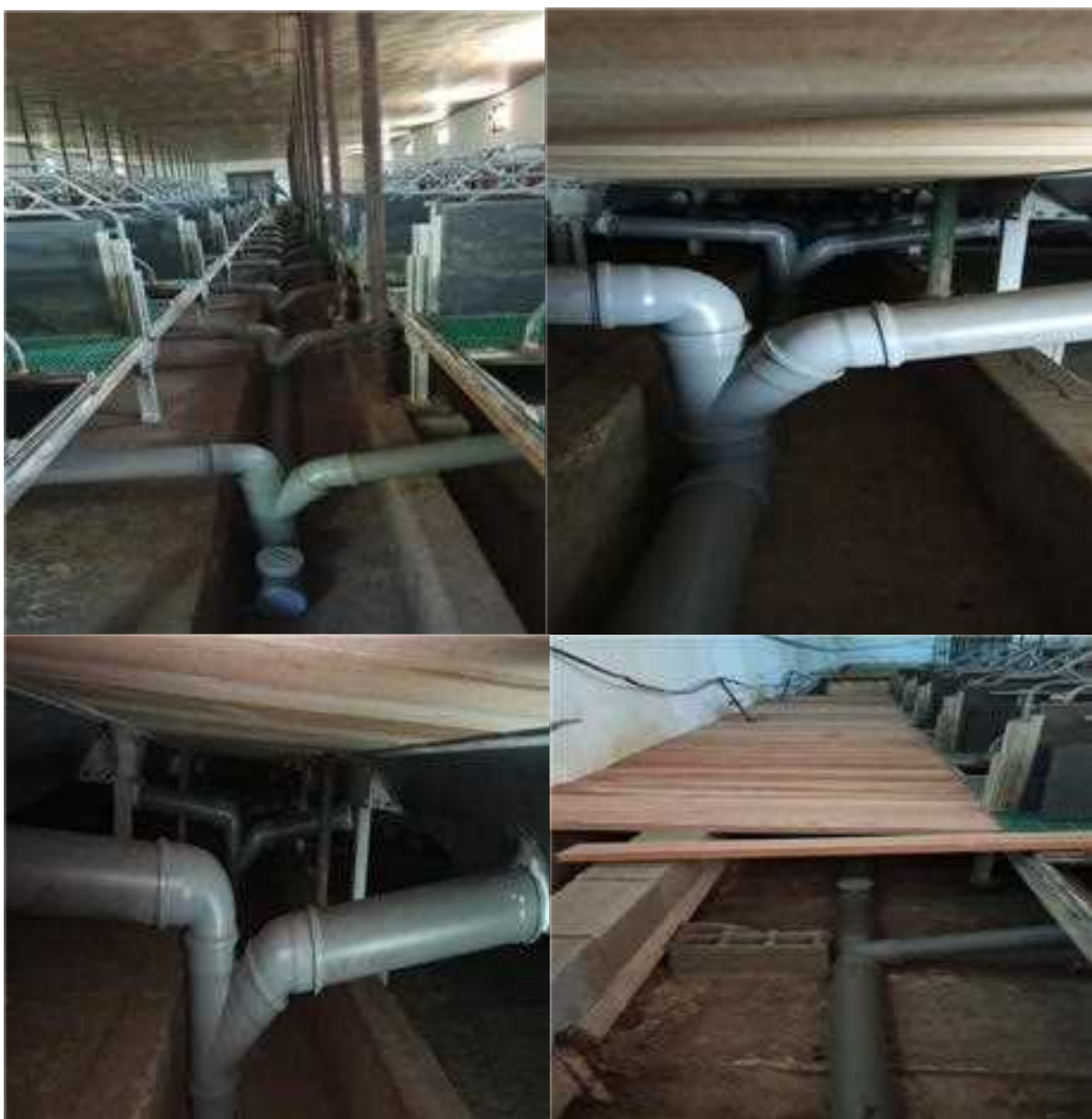
Сл.23 Систем за одведување на течен отпад
